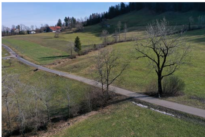
Goldbachstrasse, Bachdurchlass Burggraben
