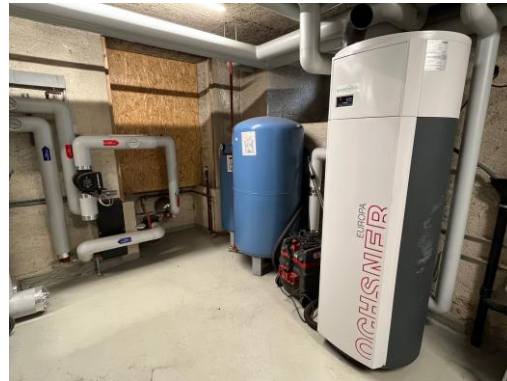
Neuer Warmwasserboiler
