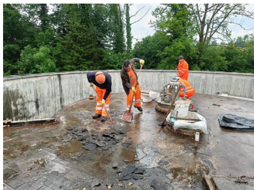
Rückbau der nicht ungenügenden Isolation und Dachabdichtung
