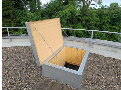
Hohlraum zwischen Konus und Holzdach
