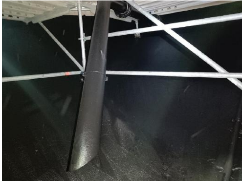
wurden mit Epoxy-Beschichtung versiegelt
