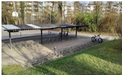
Velounterstand Schulhaus Lindenberg / Widacher
