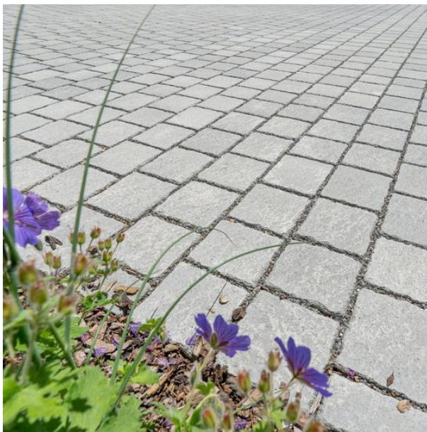
Abbildung 8 Pflasterstein "Frieda Drain Ökosteine" von Creabeton (Quelle: Creabeton)
