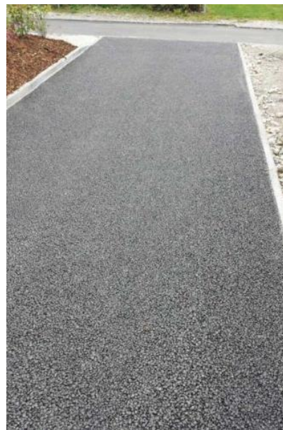
Abbildung 9 Sickerbelag (Quelle: kaderli.ch)
