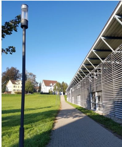
Bestehende Beleuchtung Fusswege
