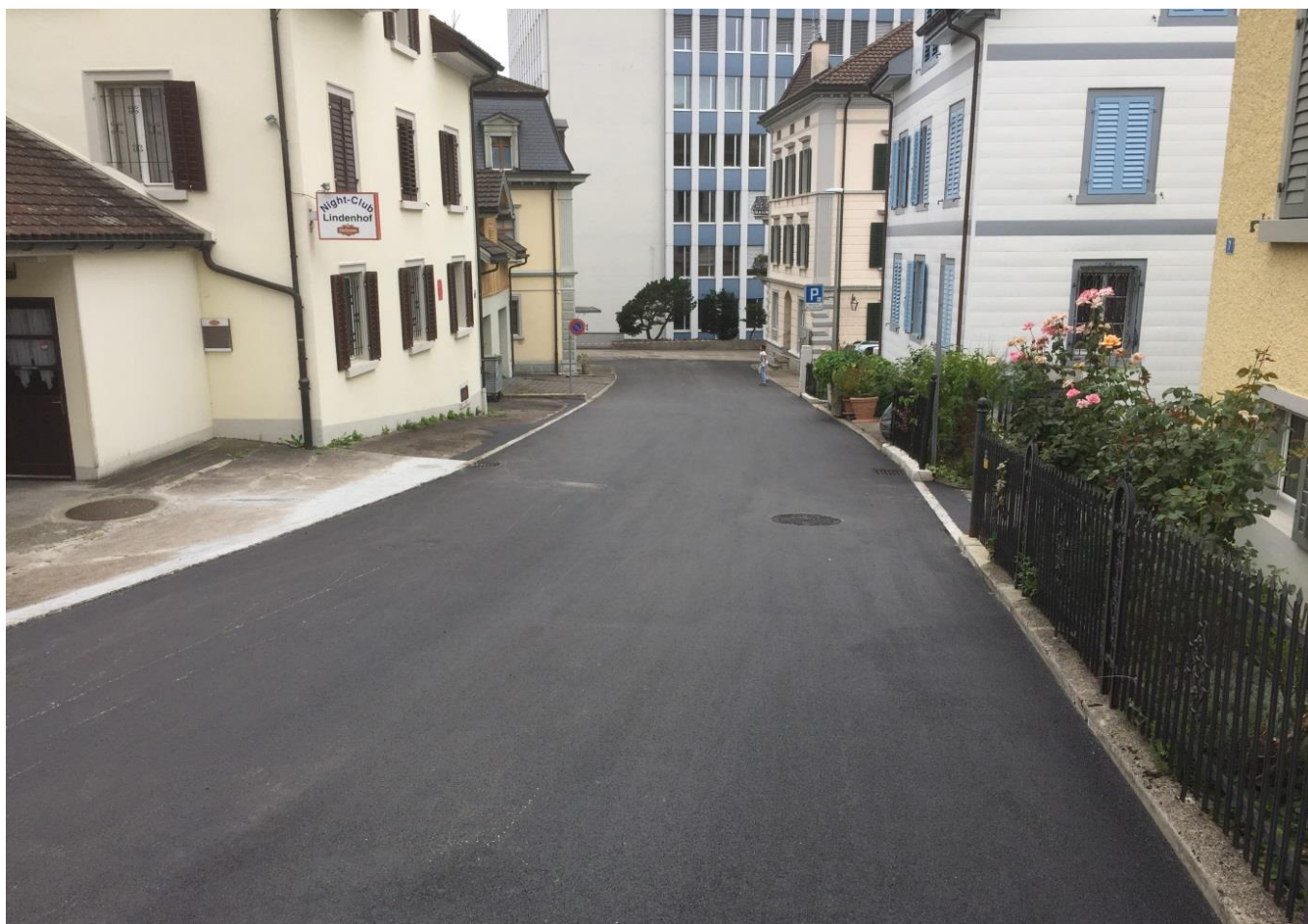
Neuer Deckbelag Falkenstrasse
