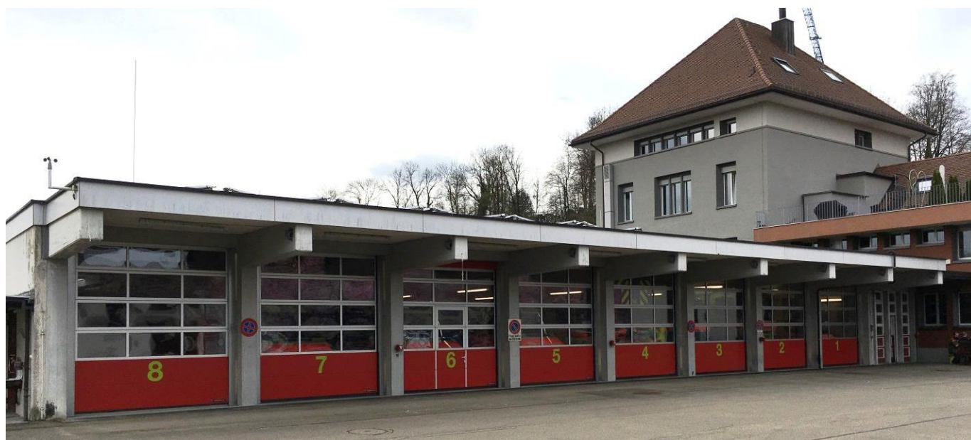
Fenster- und Torsersatz Feuerwehrgebäude
