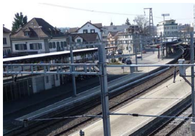
Veloabstellanlage am Bahnhof Rüti
