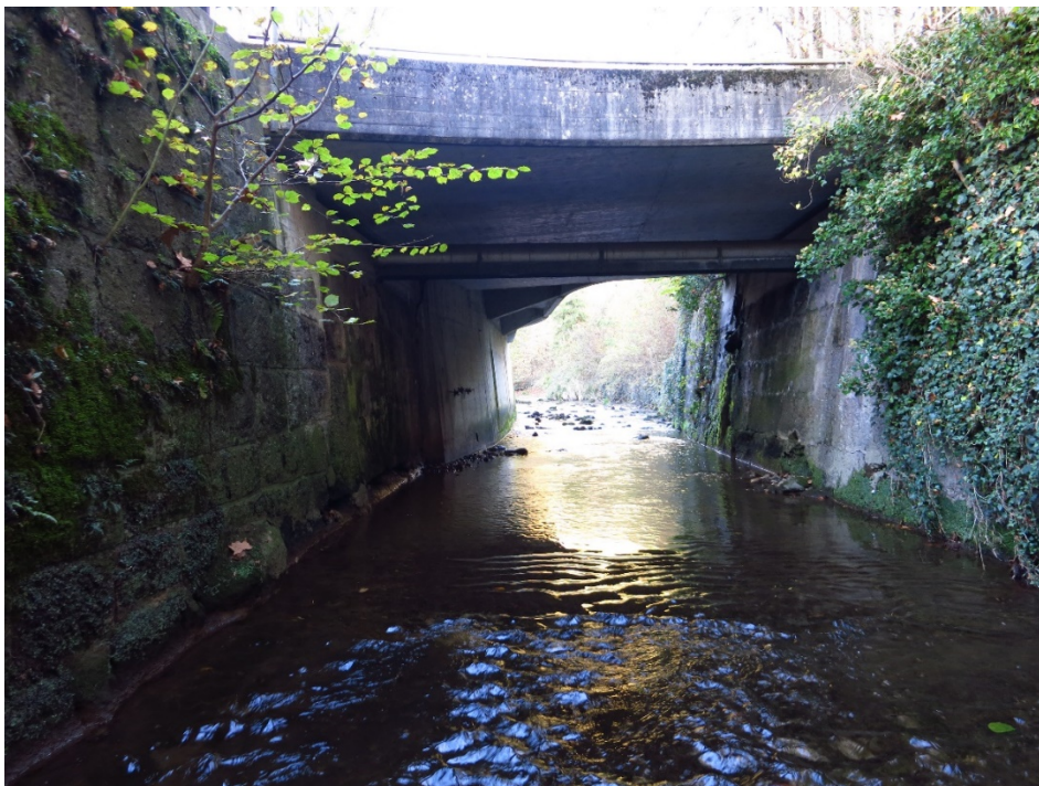
Abb. 2 Ansicht Brücke, flussseitig. Blick gegen Fließrichtung.
