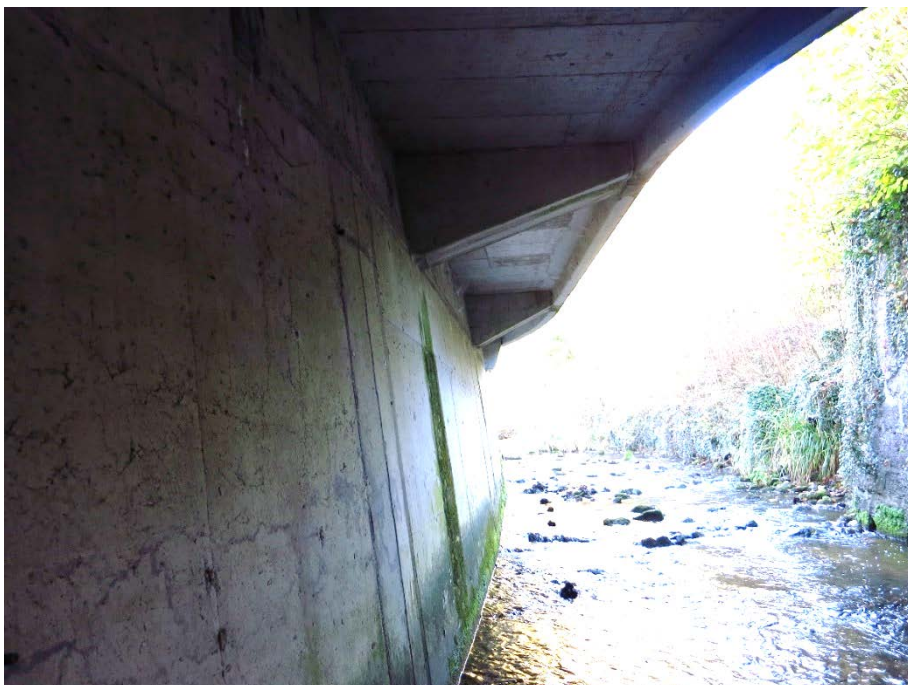
Abb. 6 Auskragung Untenansicht
