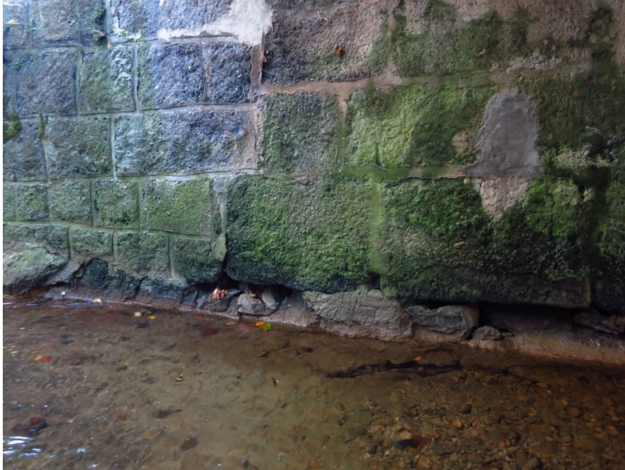
Abb. 3 Unterspülung Widerlagerwände
