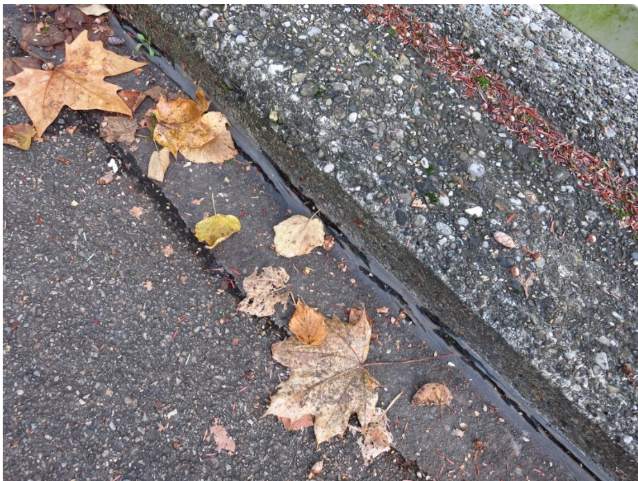
Abb. 8 Wasserdurchlässige Randsteinfuge
