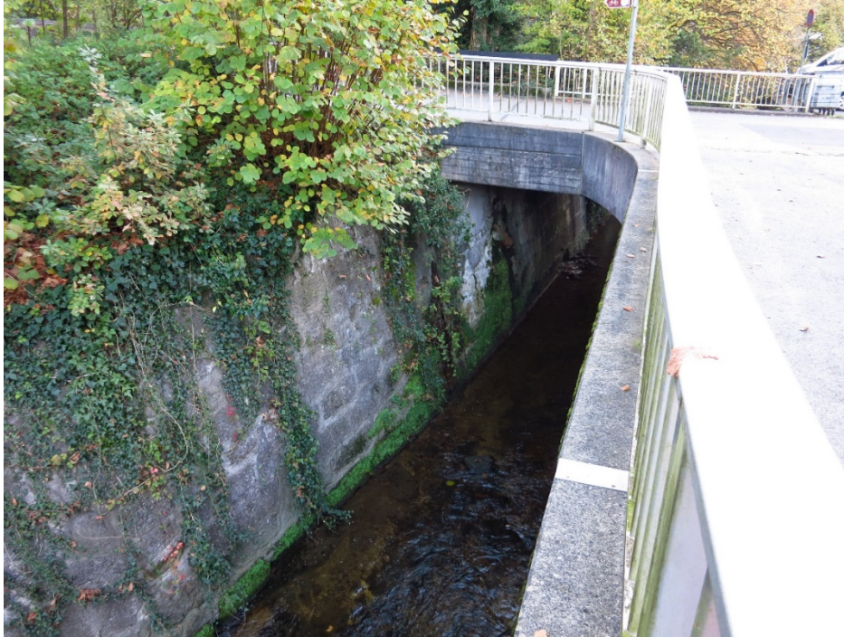
Abb. 1 Auskragung über Fluss (oberwasserseitig)
