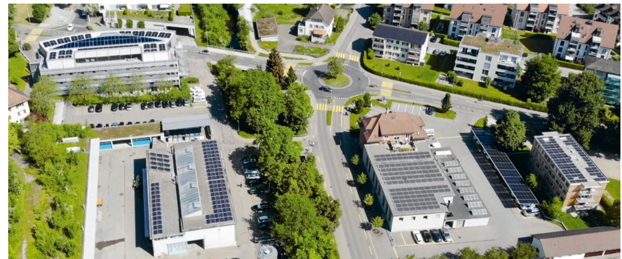
Auf den Dächern der Gemeindeliegenschaften wird die Sonnenergie konsequent genutzt. Auf dem Bild, von links: Gemeindehaus, Werkhof, Gemeindewerke, WohnWerk.
