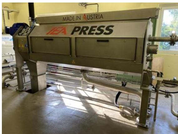
Foto: Schneckenpresse in der ARA Weidli (Bubikon/Dürnten)
