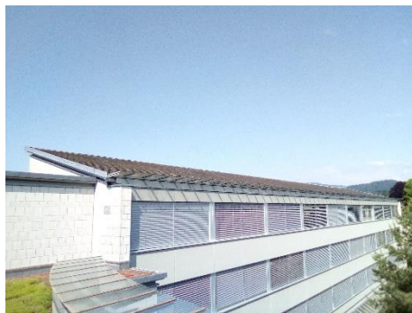
Pulldach Hauptdach Süd
