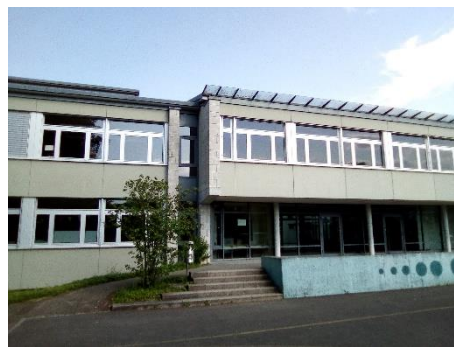
Eingangsbereich West (Steigzone Dacherschliessung in Nische)
