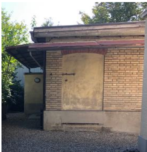
Westfassade vor der Sanierung
