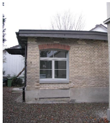
Westfassade nach der Sanierung neu mit Fenster
