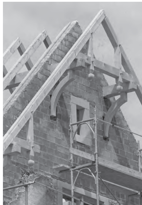
Grosse Herausforderungen für die Fachhandwerker beim Umbau des Amthauses
