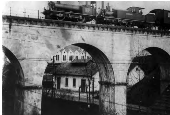
Zug der Vereinigten Schweizerbahnen auf der Dreibogenbrücke über die Jona, 1875
