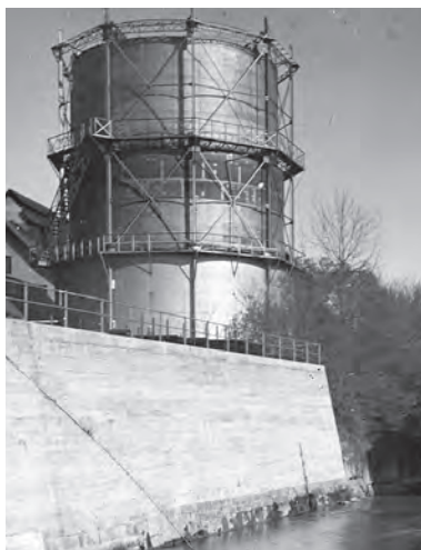
Gaswerk nach seiner Betriebsaufnahme
