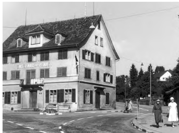
«Pfauen»: einst stattliche Klosterherberge, am Schluss verwahrlost und als Verkehrshindernis abgebrochen
