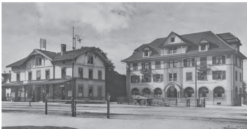
Bahnhof und Post mit der Bankgesellschaft 1928
