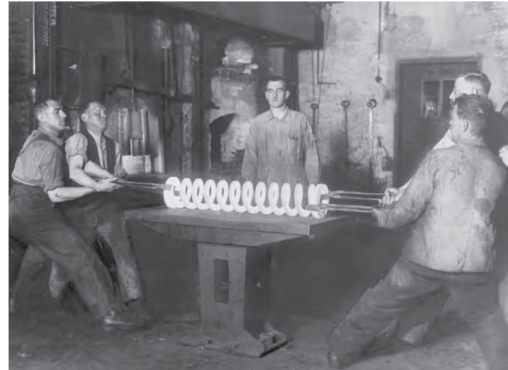
Herstellung einer Stahlfeder in Handarbeit bei Baumann
