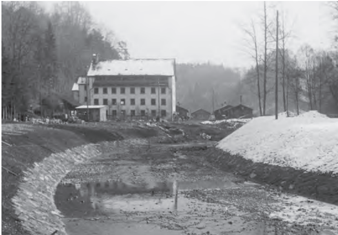
Korrektur der Jona oberhalb der Joweid. In der Bildmitte das alte Fabrikgebäude (ehem. mechanische Fabrik Amrein).
