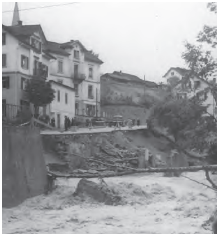
Die zerstörte Hauptstrasse mit der reissenden Jona beim Bahnviadukt
