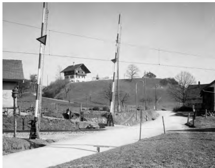
Eschenbacherstrasse beim Bahnübergang Schürwies
