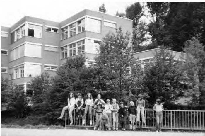
Schulhaus Widacher als Erweiterung der Schulanlage Lindenberg
