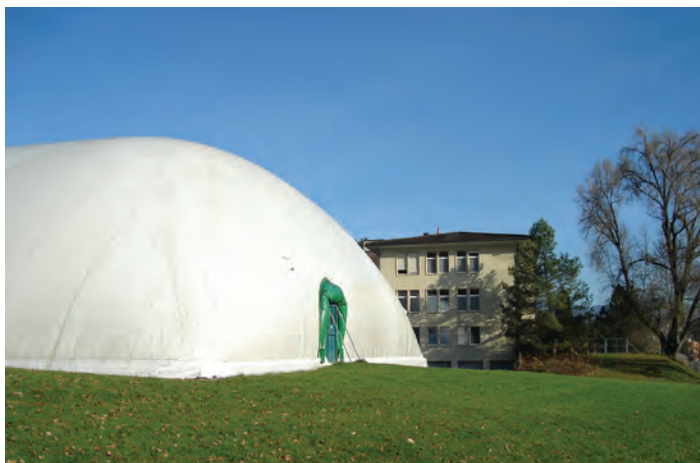
Eine Traglufthalle als Turnhallenprovisorium deutete auch äusserlich auf die Umnutzung des einstigen Spitals hin.
