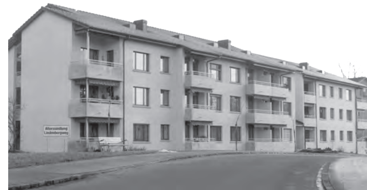
Die Erweiterung der Alterssiedlung konnte 1978 am Lindenbergweg in Betrieb genommen werden.
