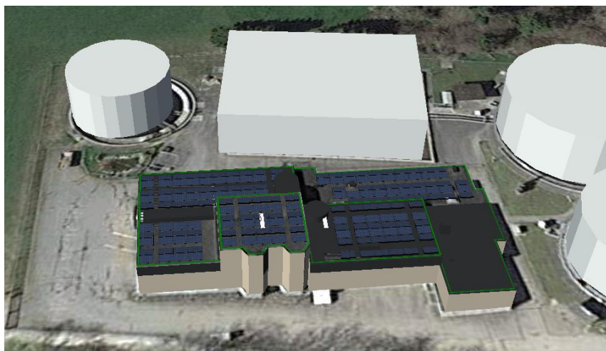
PV-Anlage Betriebsgebäude ARA
