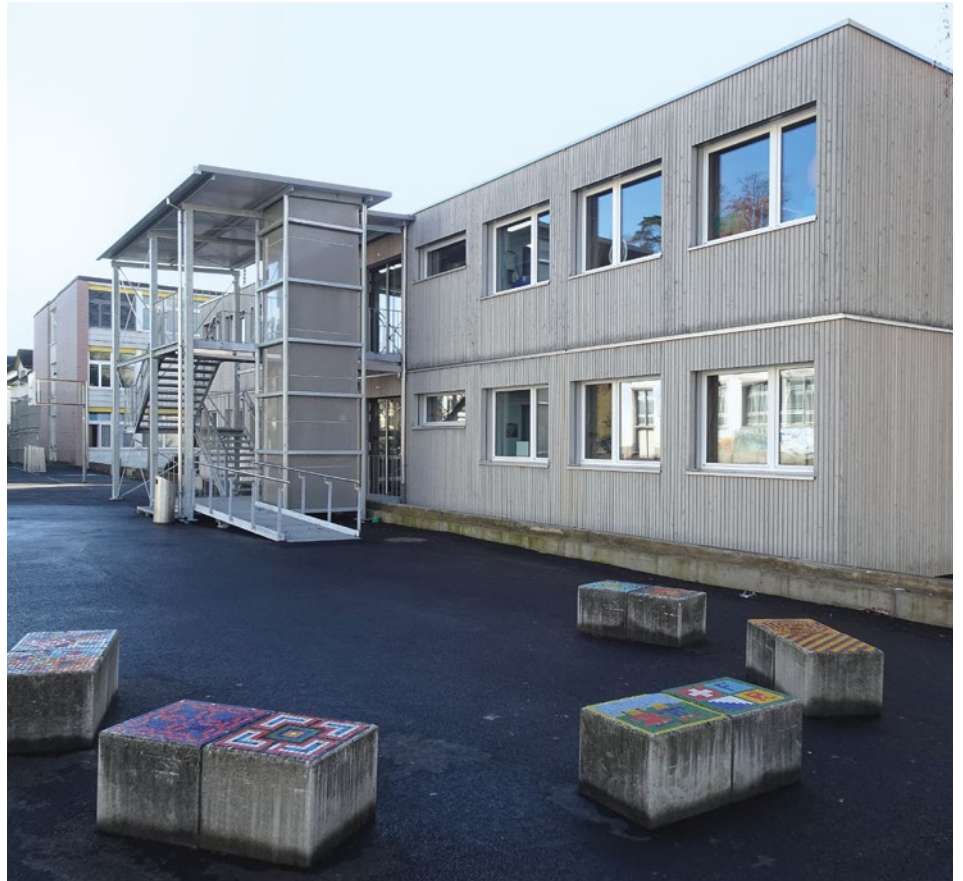
Fast neu und nachhaltig: Der Holzmodulbau ist in der Schulanlage Ferrach neu aufgebaut worden – zuvor diente er zwei Jahre in Zürich als Schulhaus.
